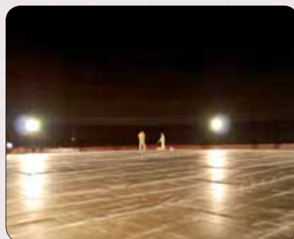
Doppelboden für Stehtank
