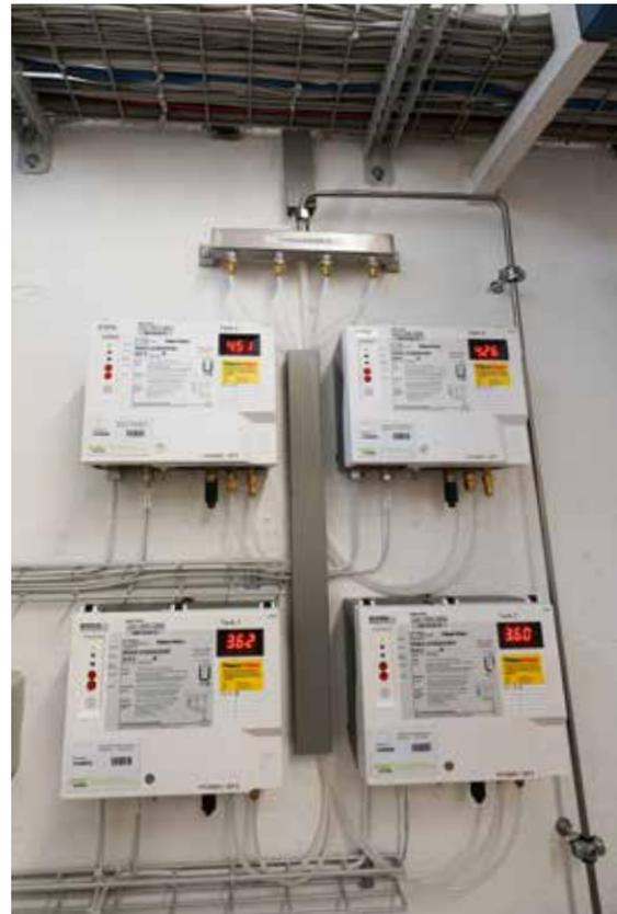
Les appareils de surveillance utilisés pour les conduites en acier inox à double paroi.
