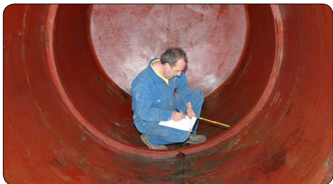
Prise des dimensions pour la confection de l'enveloppe intérieure
