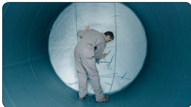
Adaptation de l'enveloppe intérieure dans la citerne
