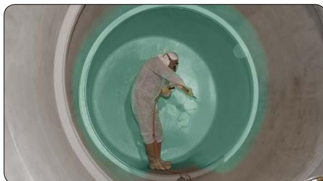
Application du revêtement
