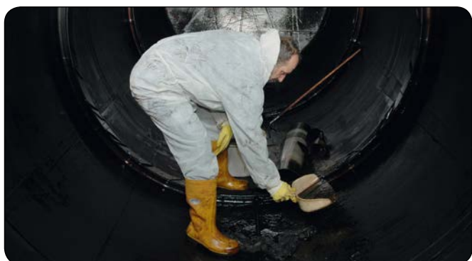
Suppression des boues de mazout
