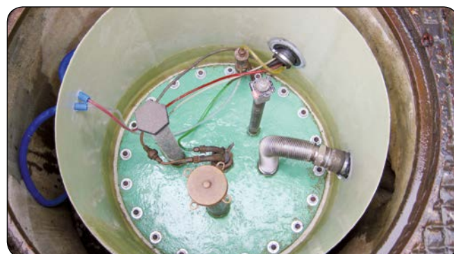
La citerne assainie avec sa nouvelle chambre étanche
