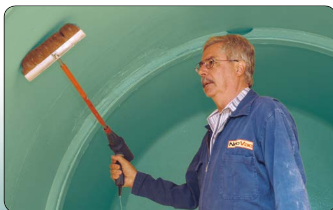
Contrôle et réception de l'installation
